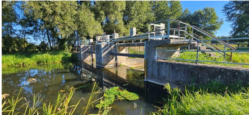
Abbildung 1-3: Wehr Beelitz, Blick vom Oberwasser (DHI, 04.09.2023).
